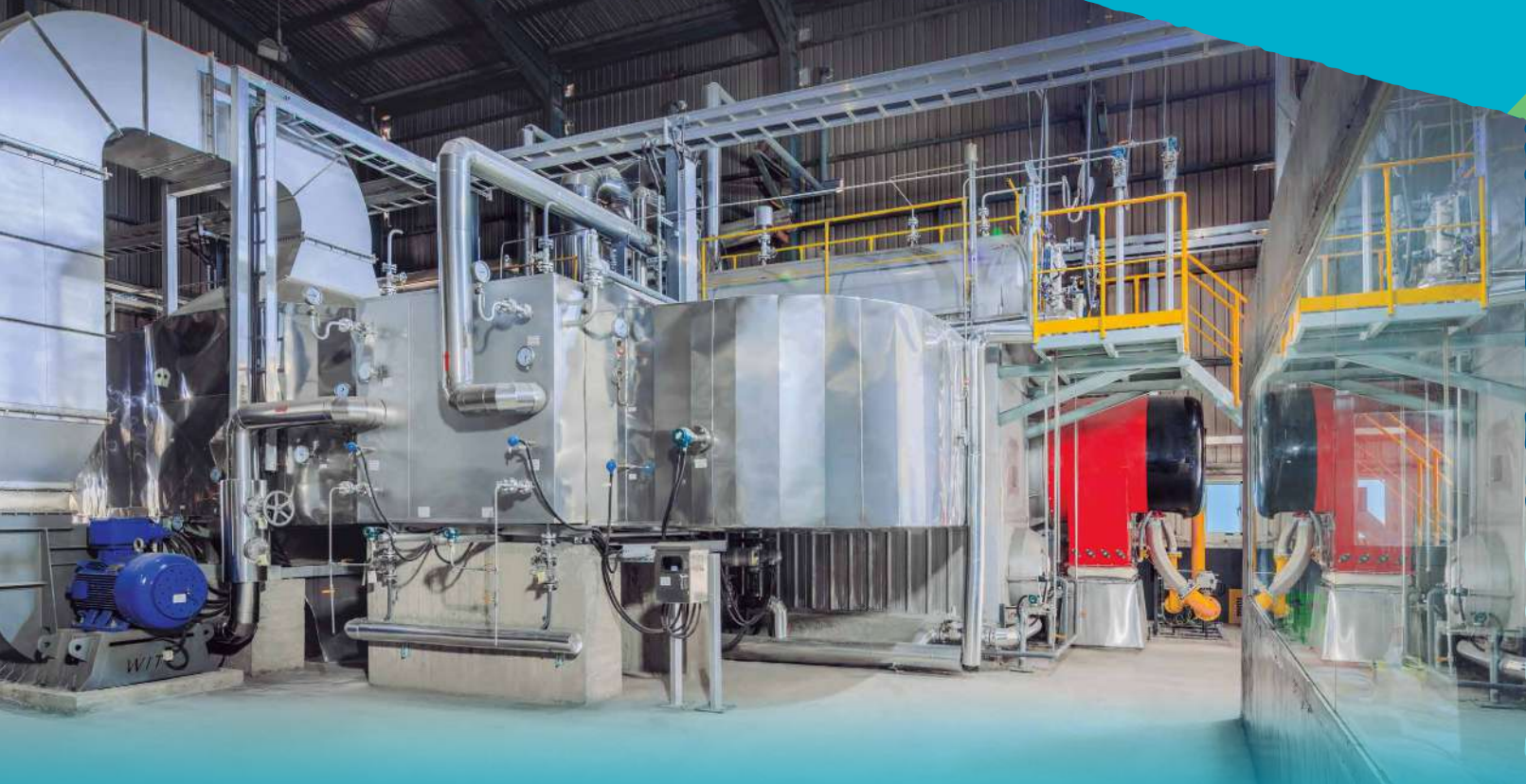
清水廠 天然氣鍋爐2025第一季完工啟用
